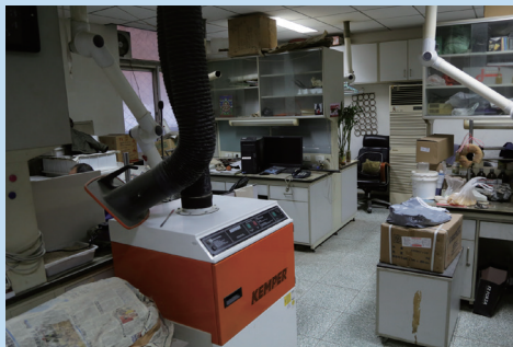
新改造的化石修理室排风系统
